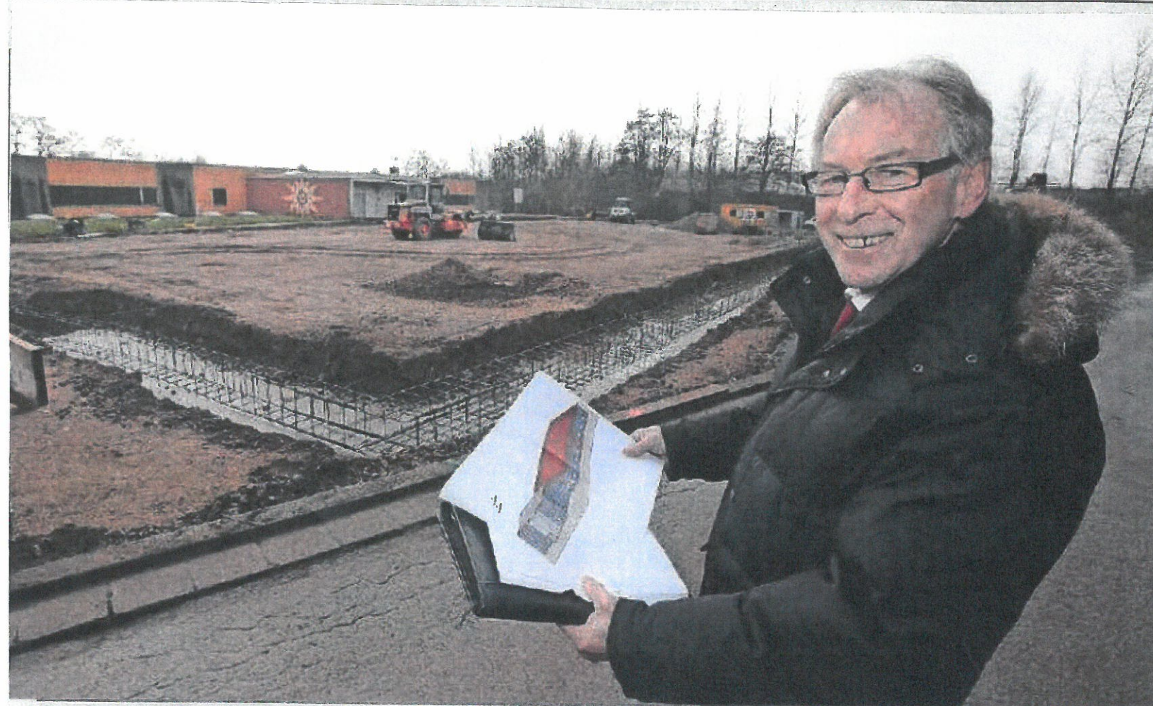
Gerd Barthen steht vor dem Bauplatz des zukünftigen Schulungszentrums. FOTO: THOMAS SEEBER
