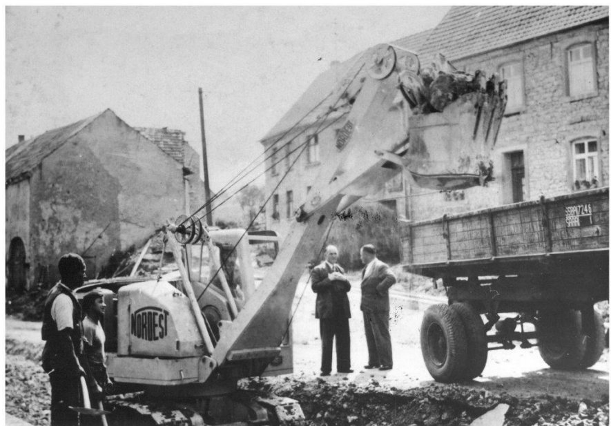
Der kleinere „NORD-EST“ Bagger mit Hochlöffel
