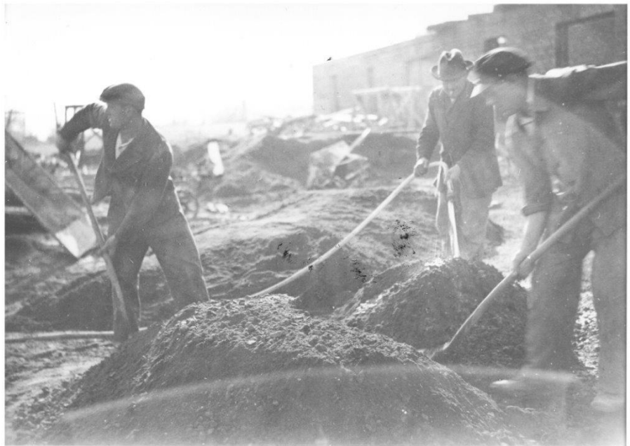
Betonherstellung 1934
