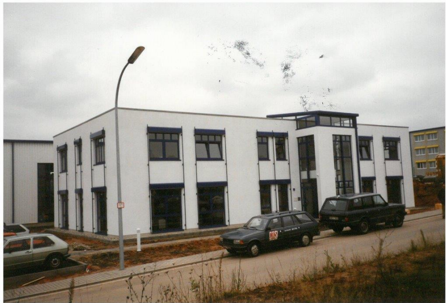
Verwaltungsgebäude HERWECK AG 1993
