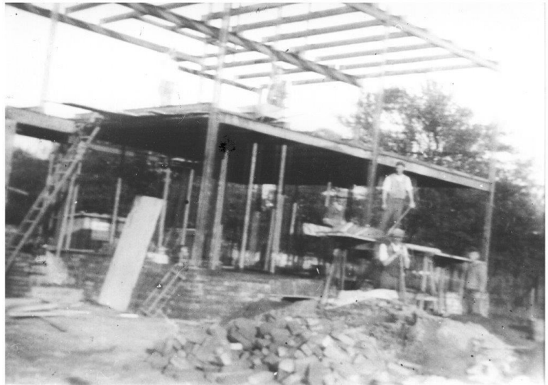
Wohnhaus im Stahlskelettbau in Gersweiler
