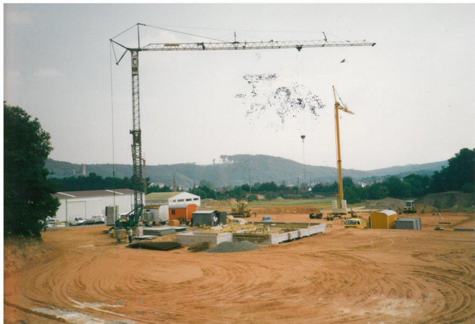
Baubeginn der neuen Firmengebäude in Kirkel 1991
