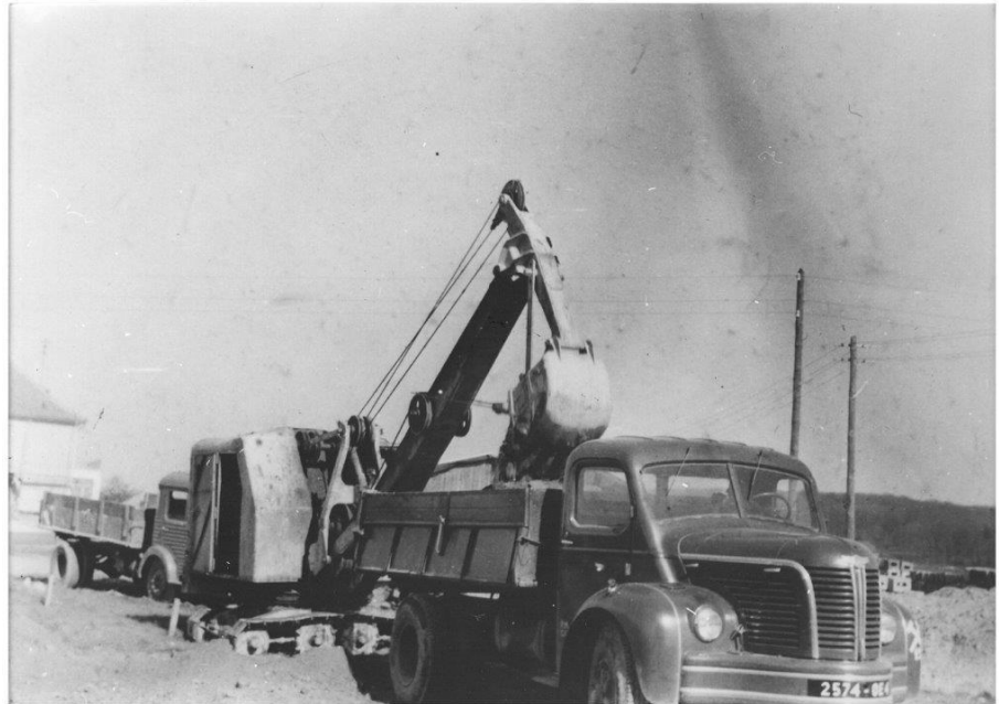
Der erste Seilzugbagger „Oma“ genannt belädt einen „Berliet“
