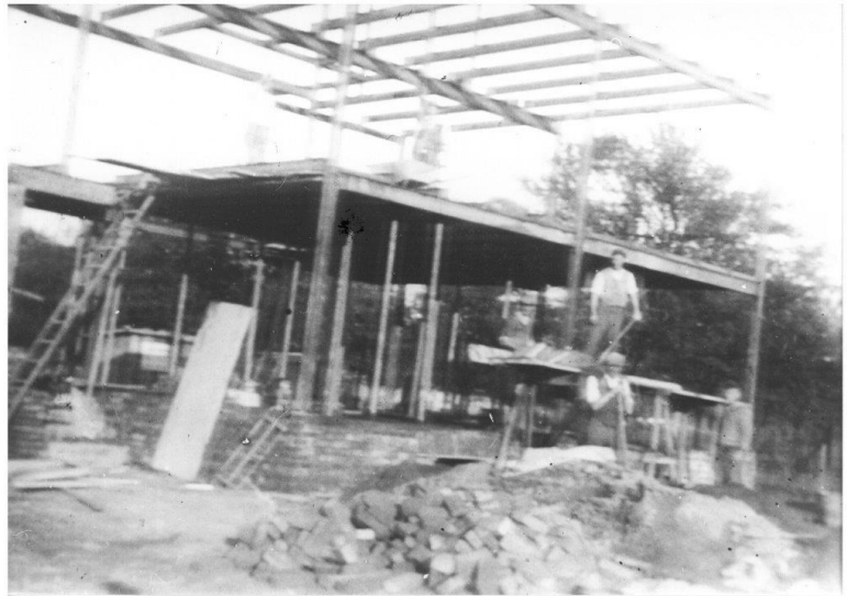
Wohnhaus im Stahlskelettbau in Gersweiler
