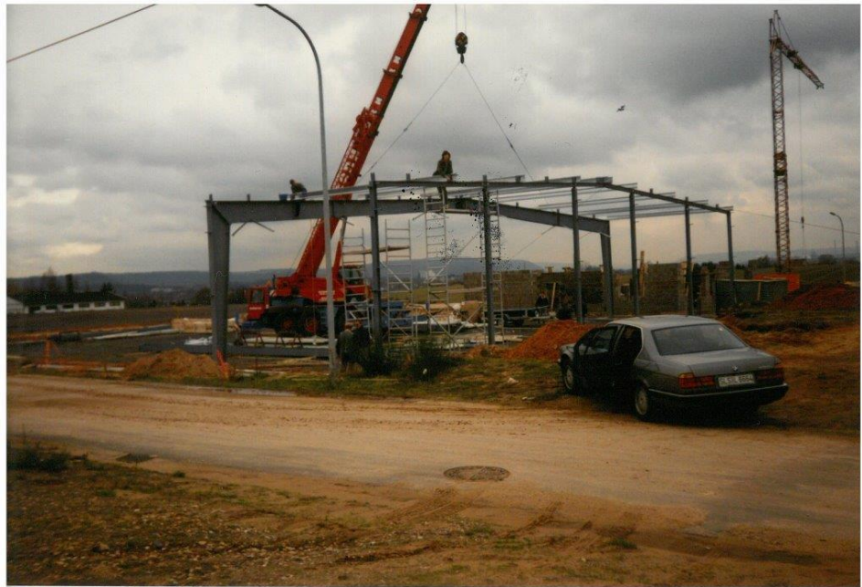
Stahlhallenmontage EKU Kabel in Ens Dorf 1989
